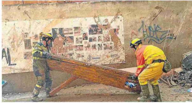
Efectivos de Sarga e Infoar colaboran para retirar una puerta de una calle de Catarroja. GOBIERNO DE ARAGON
